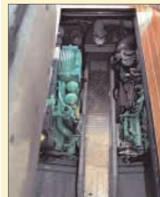
La cámara de motores, bajo el salón, cuenta con una gran trampilla de acceso y un magnánimo espacio interior.
